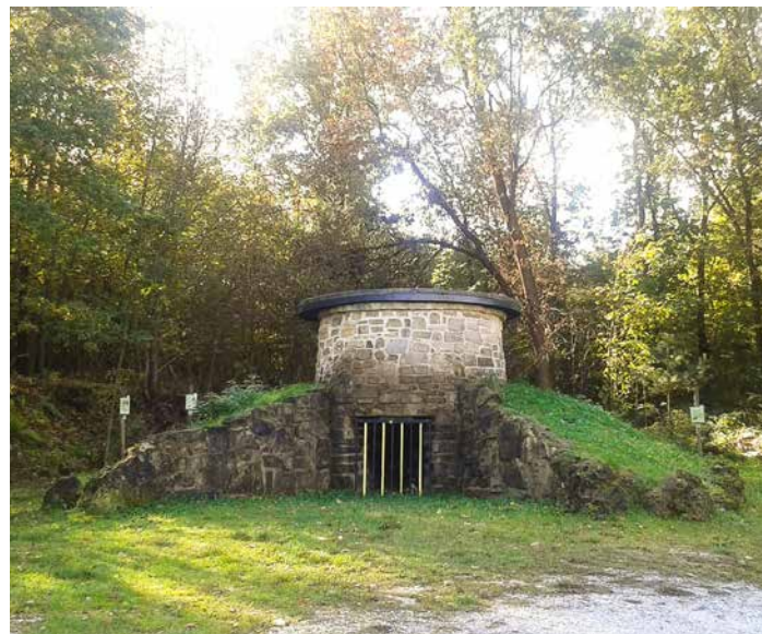
Historischer Gipsbrennofen Neuhoof | Foto: © Corinna Behnk
